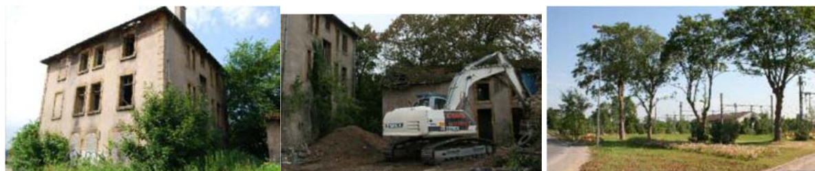
Aménagement des espaces publics : entrée du quartier du Roi, avant, pendant et après les travaux
